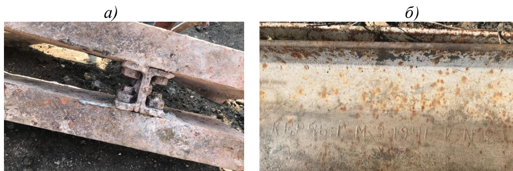
Рис. 1. Фото металлических конструкций (спаренные элементы колонны, двутавровая балка). Объекты расположены в Ярославской области, срок эксплуатации металлических конструкций 80-100 лет
